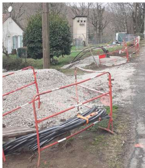
Travaux de raccordement d'une centrale photovoltaïque au réseau
